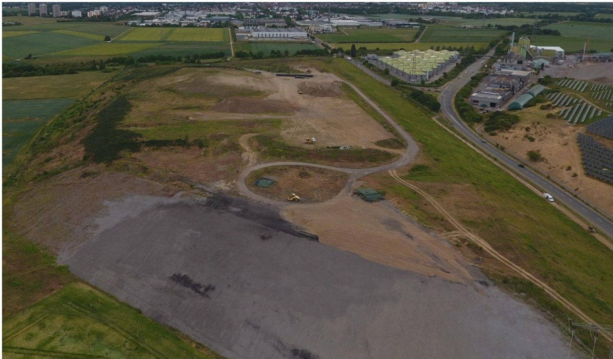
Abb. 26: Altlast „Fläche E“ angrenzend an den Deponiepark Flörsheim-Wicker (rechts) (Mai 2025)
