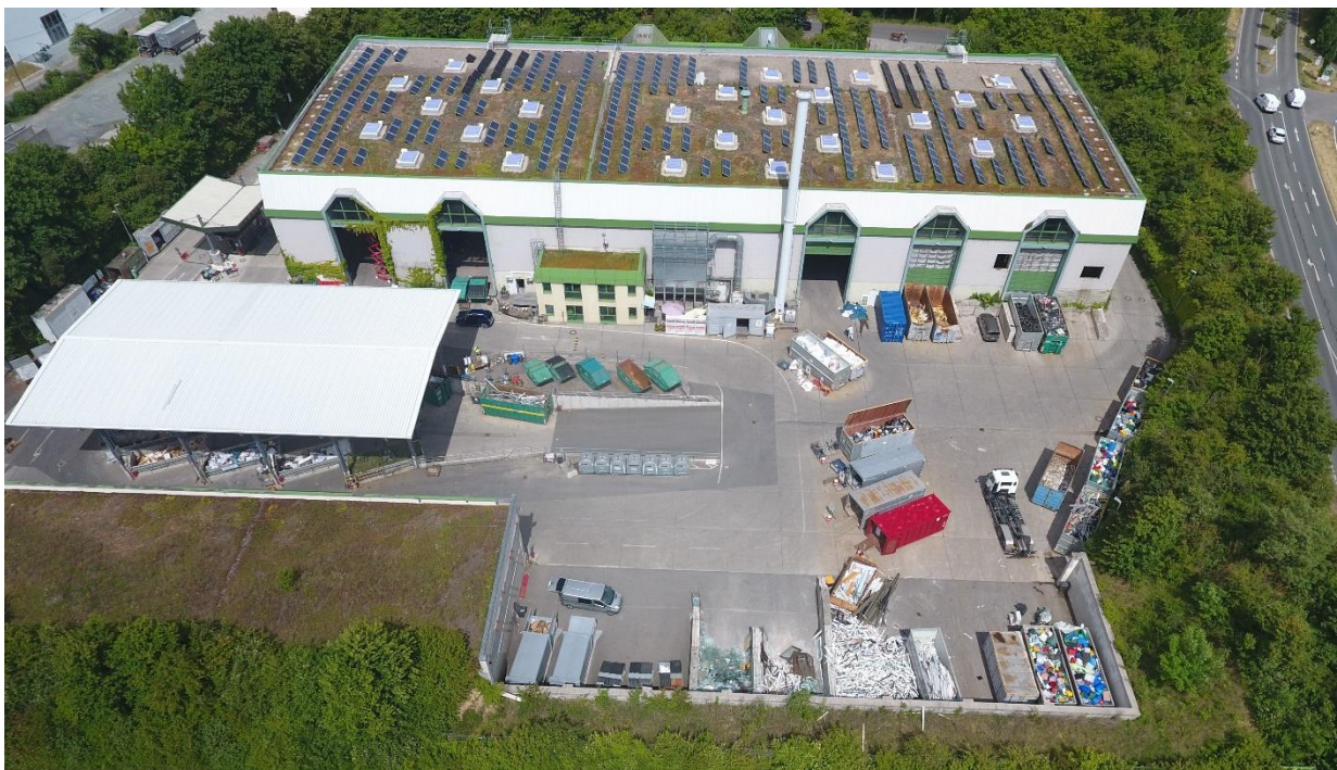
Abb. 19: Übersicht Wertstoffhof am Standort Steinmühlenweg 2 in Flörsheim-Wicker (Mai 2025)
