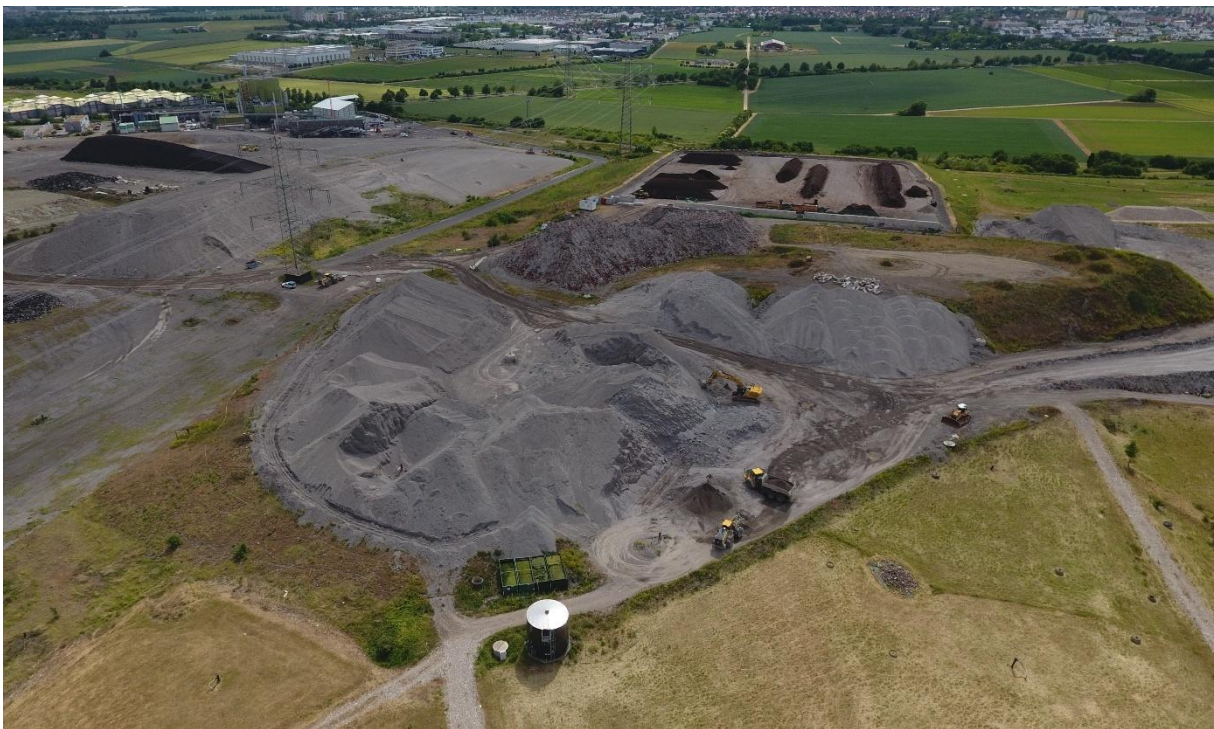
Abb. 25: Schlackelager auf der Deponie Wicker (Mai 2025)
