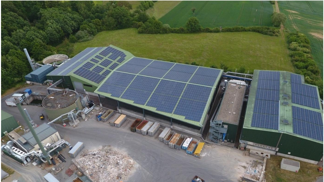
Abb. 15: Übersicht Biogasanlage Brandholz mit angeschlossener Gasverwertungsanlage (links unten) (Mai 2025)
