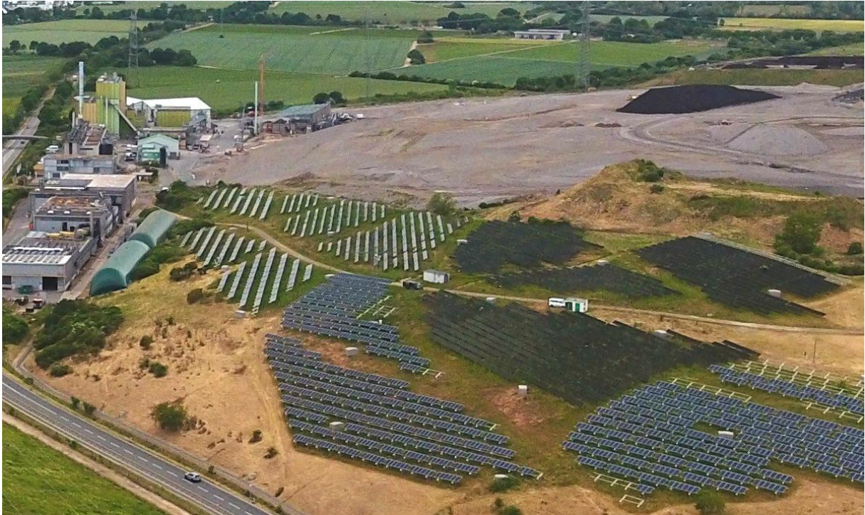
Abb. 31: Überblick Freiflächen-PV-Anlage auf der Fläche A der Deponie Wicker (Mai 2025)
