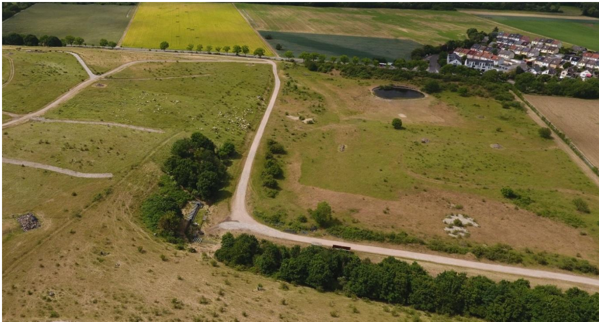
Abb. 48: Feuchtbiotop auf dem Deponiegelände in Flörsheim-Wicker (rechts), Schafbeweidung auf rekultivierter Fläche und Steinschmätzer Brutstätte (links) (Mai 2025)
