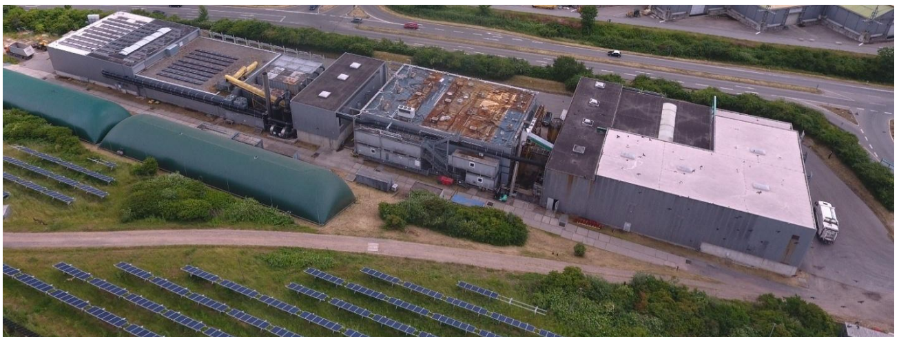
Abb. 14: Bioabfallvergärungsanlage (Biogasanlage) im Deponiepark Flörsheim-Wicker (Mai 2025)
