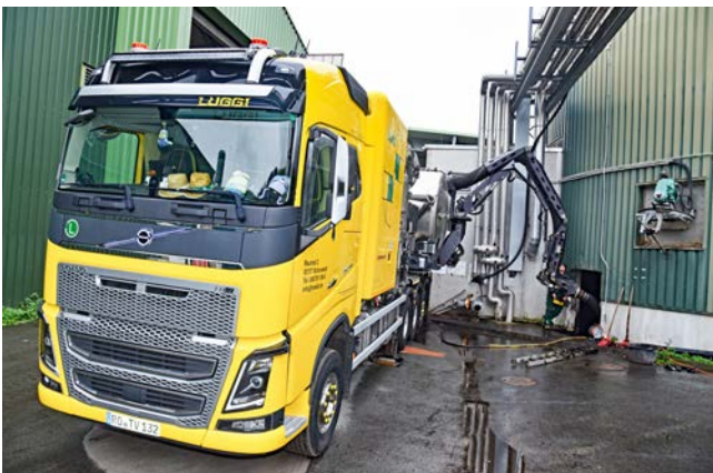
Der Saugbagger ist direkt neben dem zu reinigenden Behälter platziert.
